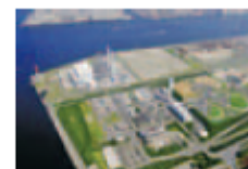
Ohgishima LNG Terminal
