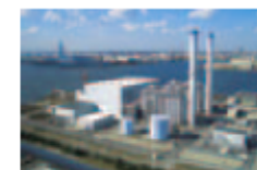
Ohgishima Power Co., Ltd.
