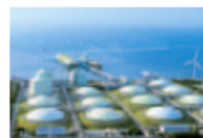
Sodegaura LNG Terminal
